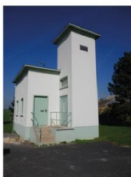
Captage AEP Puits 1 de Gueux
